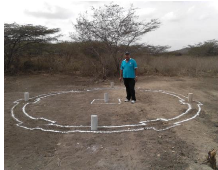
17 de marzo de 2013. Replanteo de la distribución de columnas de la cúpula principal y del pedestal del telescopio.
