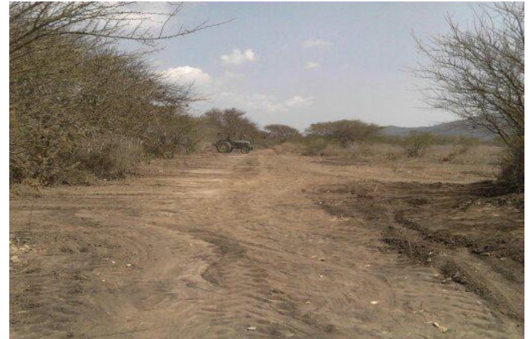
24 de enero de 2013. Ampliación de vía de acceso.
