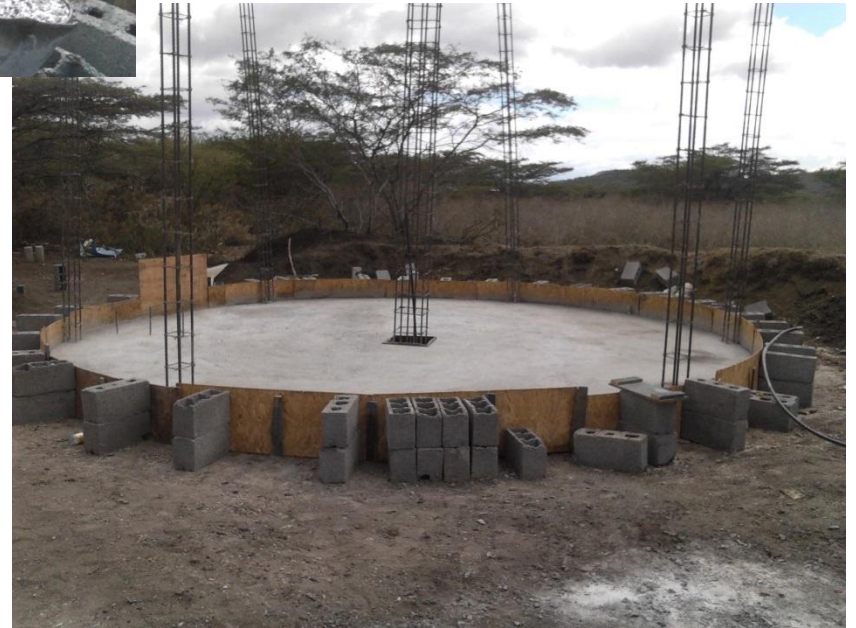
Diciembre 2013: Vaciado y Secado de la Placa en Planta Baja
