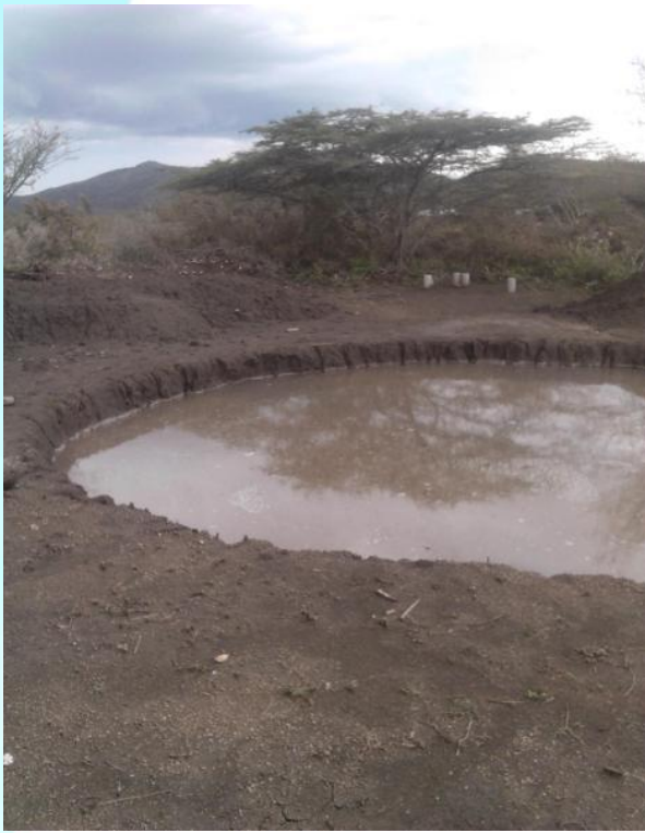
05/09/2013: Lluvias torrenciales inundan el trabajo realizado.
