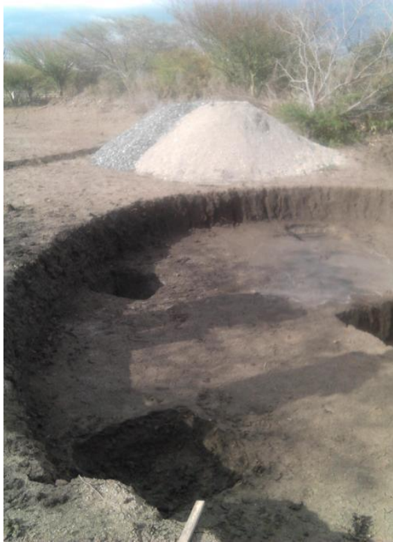
03/09/2013: excavación de huecos para las fundaciones de la cúpula principal.
