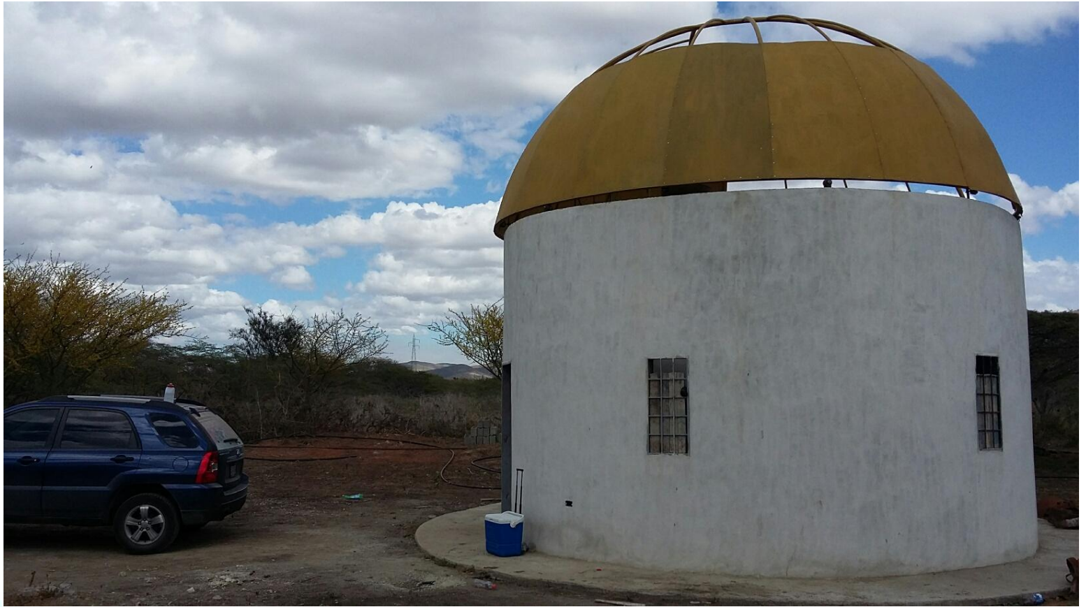
Febrero 2015: Colocación de láminas inferiores
