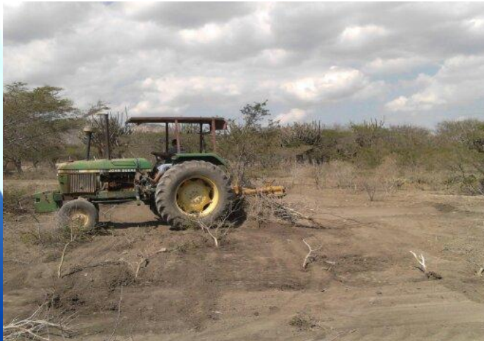
20 enero 2013. Inicio del movimiento de tierra.
