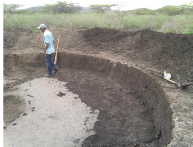
11/09/2013: Al extraer el agua, se habrá que profundizar 10 centímetros para extraer el barro y replantear los huecos para las fundaciones.
