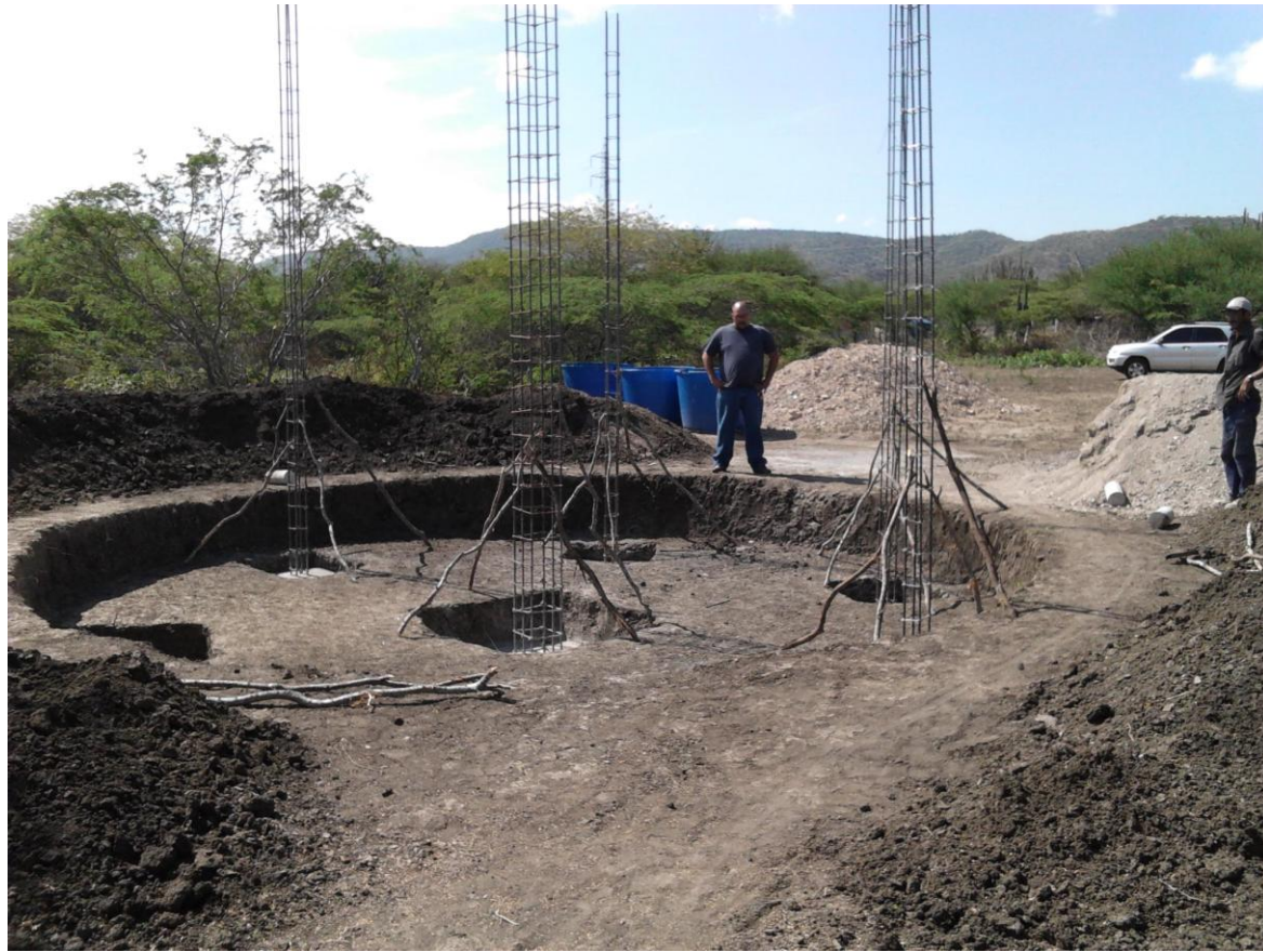
24/09/2013: colocación de estructura metálica para columnas y pedestal.
