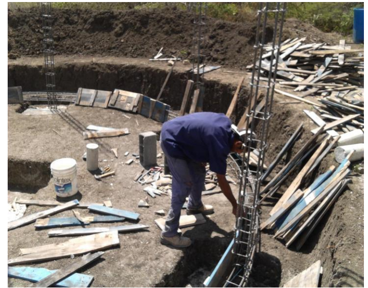
03/10/2013: construcción del encofrado de madera para el vaciado de concreto.
