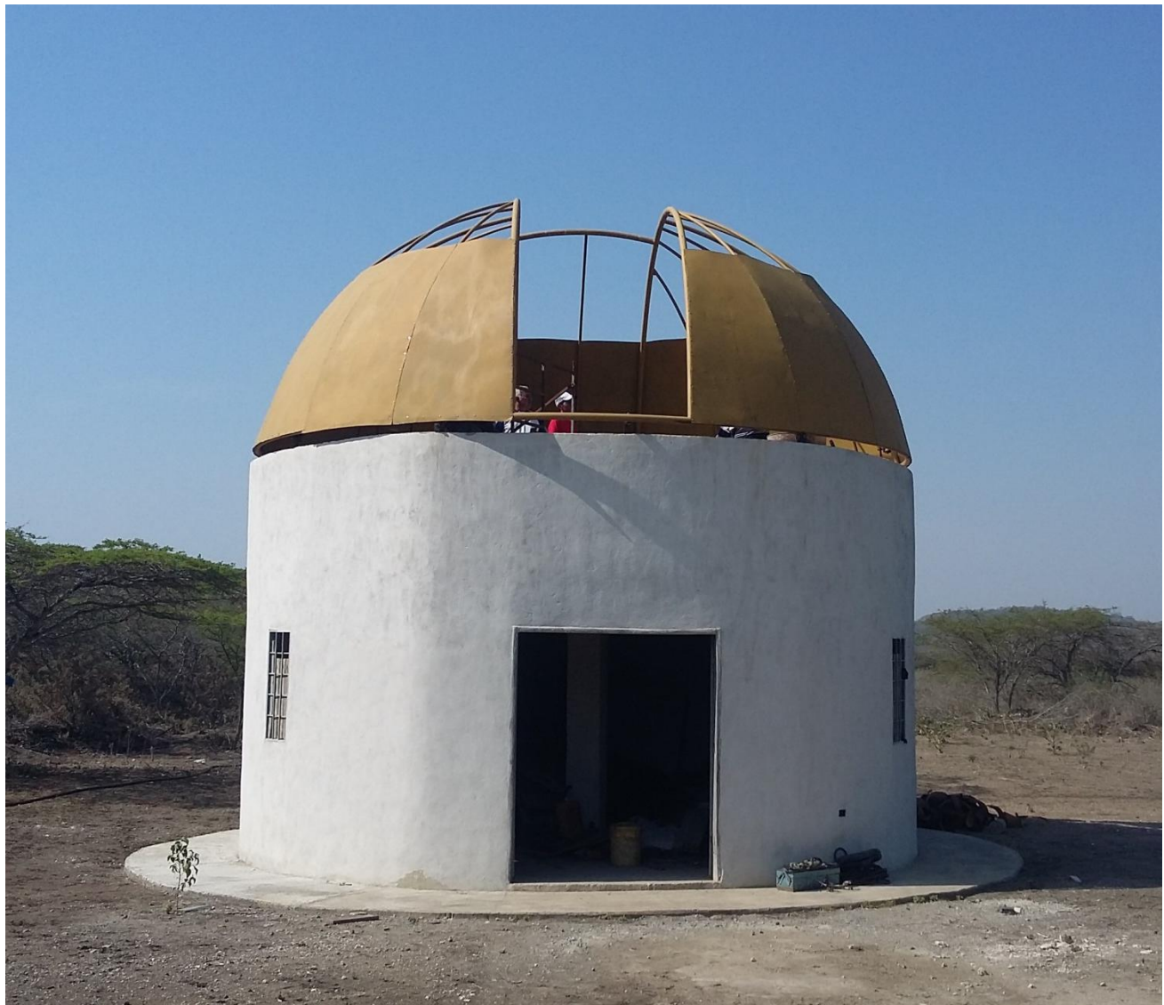
Mayo 2015: Colocación de láminas inferiores e inicio de superiores
