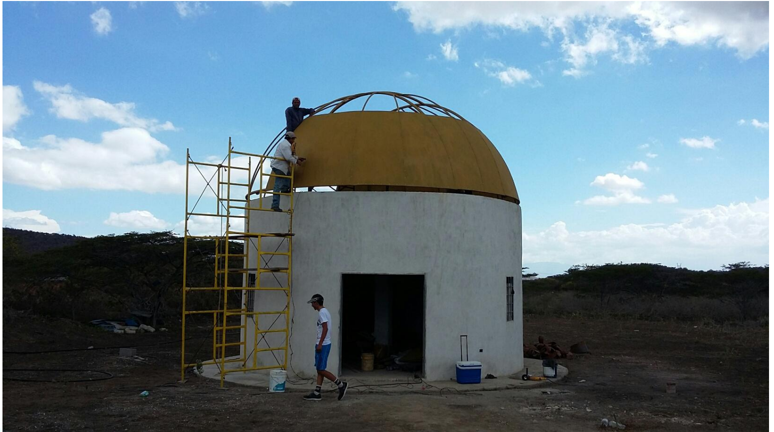
Febrero 2015: Colocación de láminas inferiores
