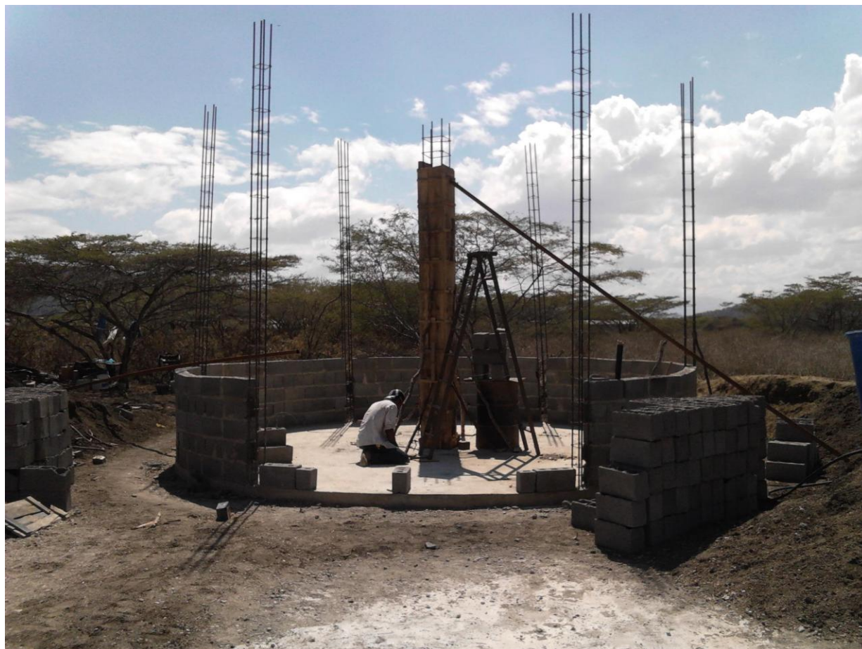
Enero 2014: Inicio de construcción de pared perimetral de la cúpula
