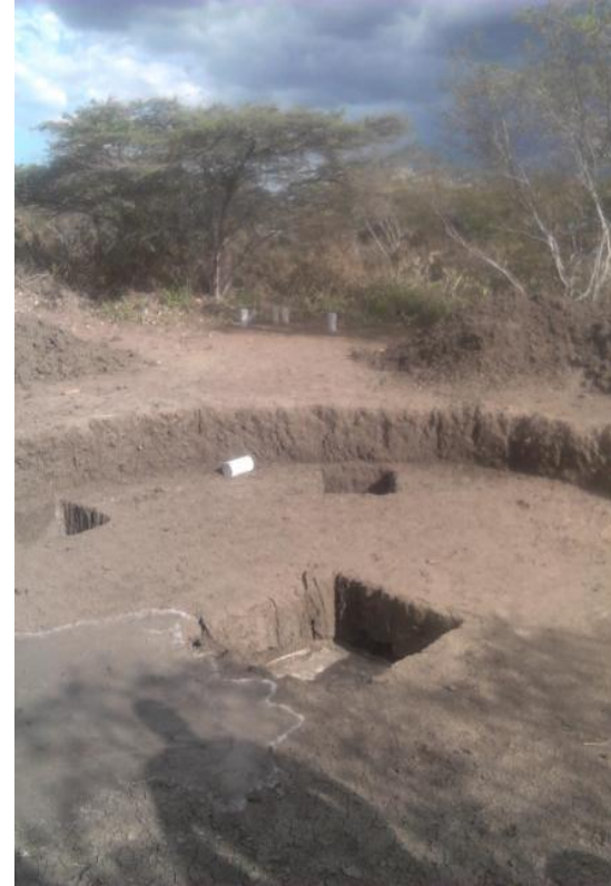
03/09/2013: excavación de huecos para las fundaciones de la cúpula principal.
