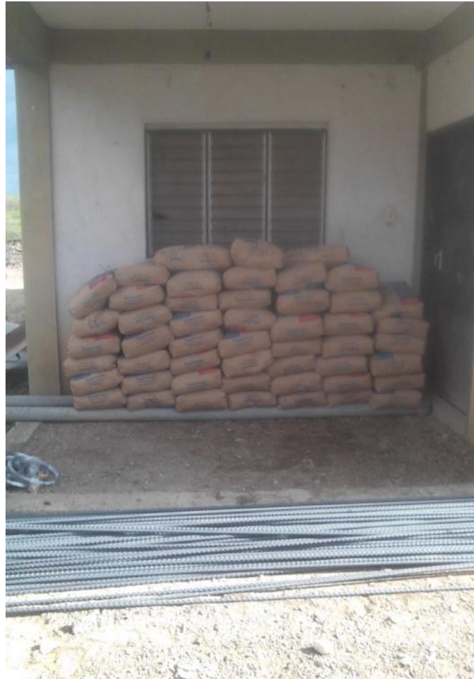
03/09/2013: acopio de cemento y cabillas para la construcción.
