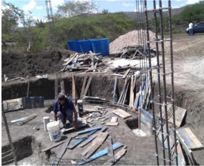
03/10/2013: construcción del encofrado de madera para el vaciado de concreto.
