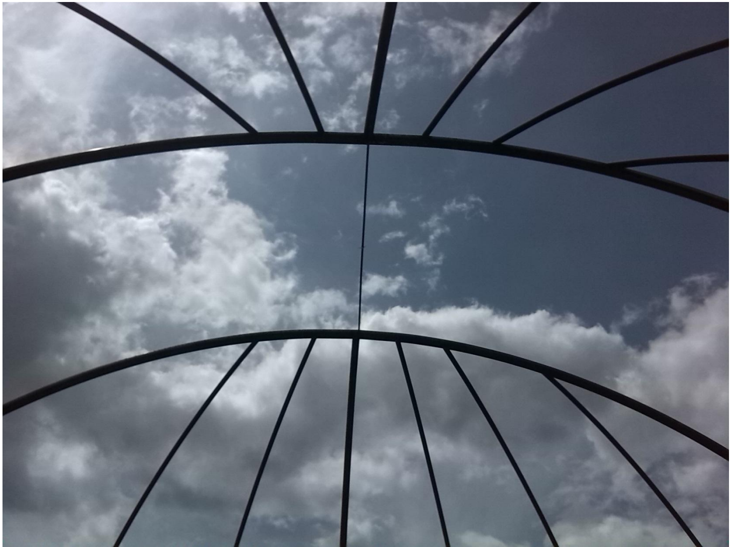
Octubre 2014: Fotografía cenital del armado
