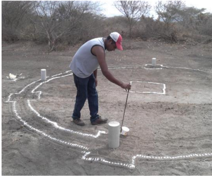
17 de marzo de 2013. Replanteo de la distribución de columnas de la cúpula principal y del pedestal del telescopio.
