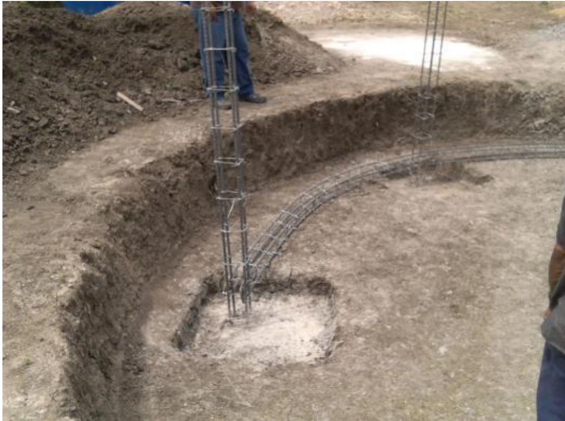
26/09/2013: Colocación de estructura metálica para la viga de arrastre.
