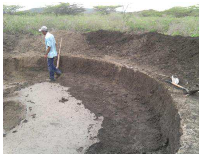
11 de septiembre: Al extraer el agua, se habrá que profundizar 10 centímetros para extraer el barro y replantear los huecos para las fundaciones.
