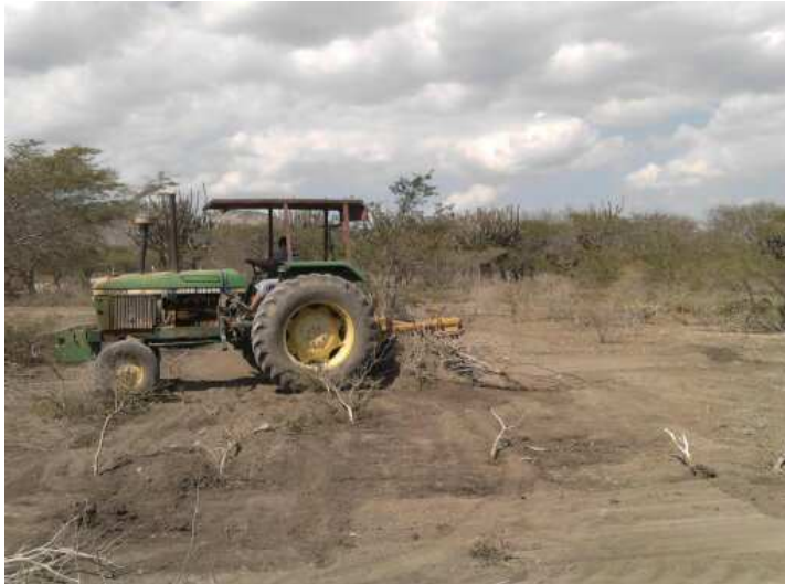
20 enero 2013. Inicio del movimiento de tierra.
