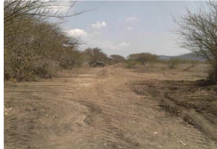
24 de enero de 2013. Ampliación de vía de acceso.
