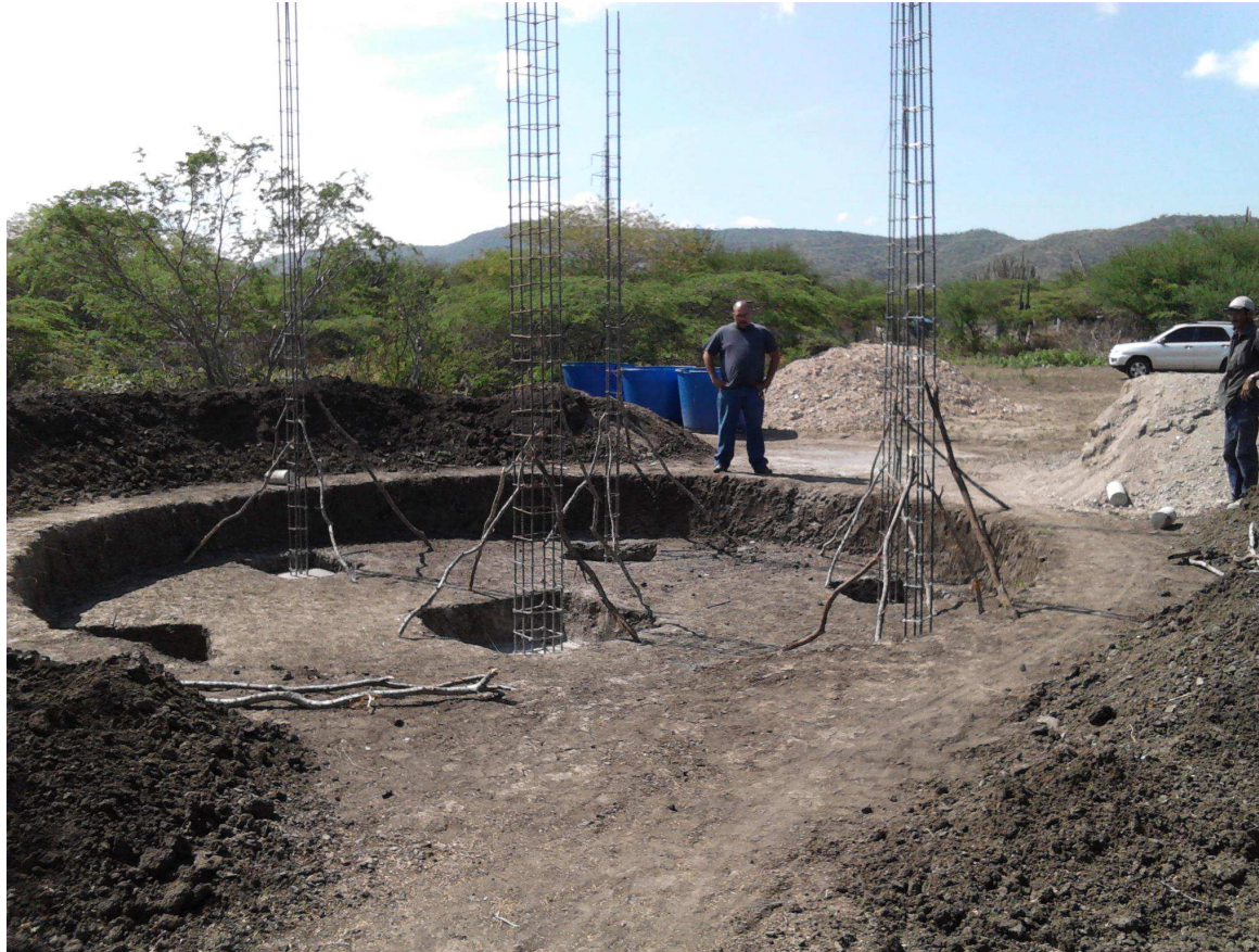
24 de septiembre: colocación de estructura metálica para columnas y pedestal.
