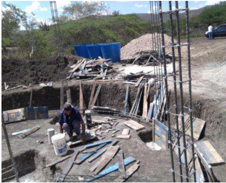
03 de octubre: construcción del encofrado de madera para el vaciado de concreto.
