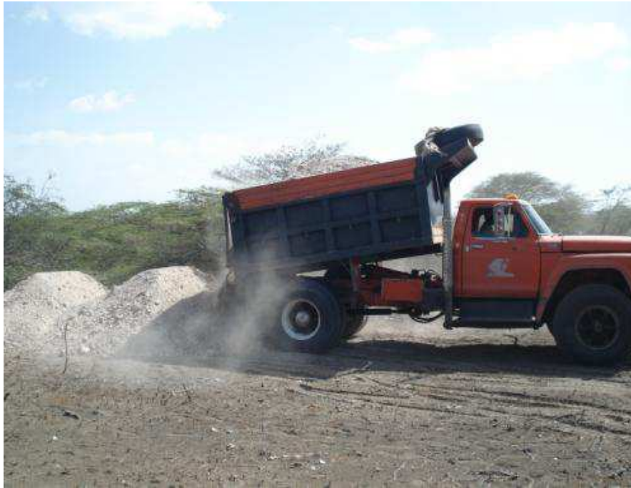
12 de julio y 04 de agosto. Acopio de materiales de construcción. Relleno, piedra y arena para construcción.
