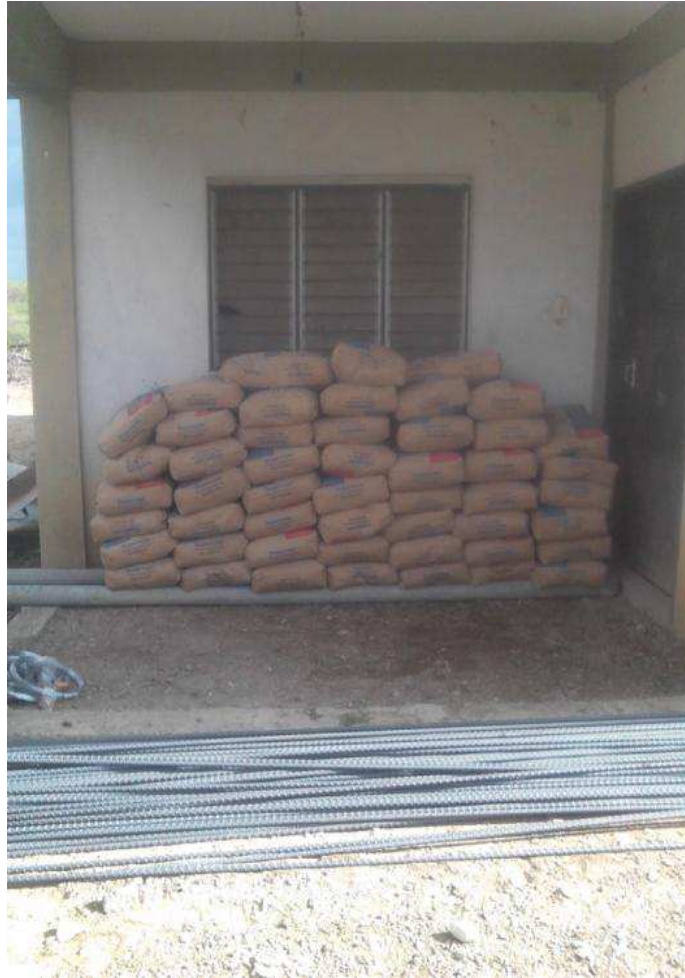
03 de septiembre: acopio de cemento y cabillas para la construcción.
