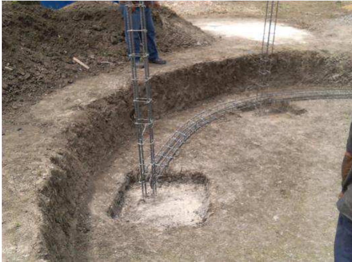
26 de septiembre: Colocación de estructura metálica para la viga de arrastre.
