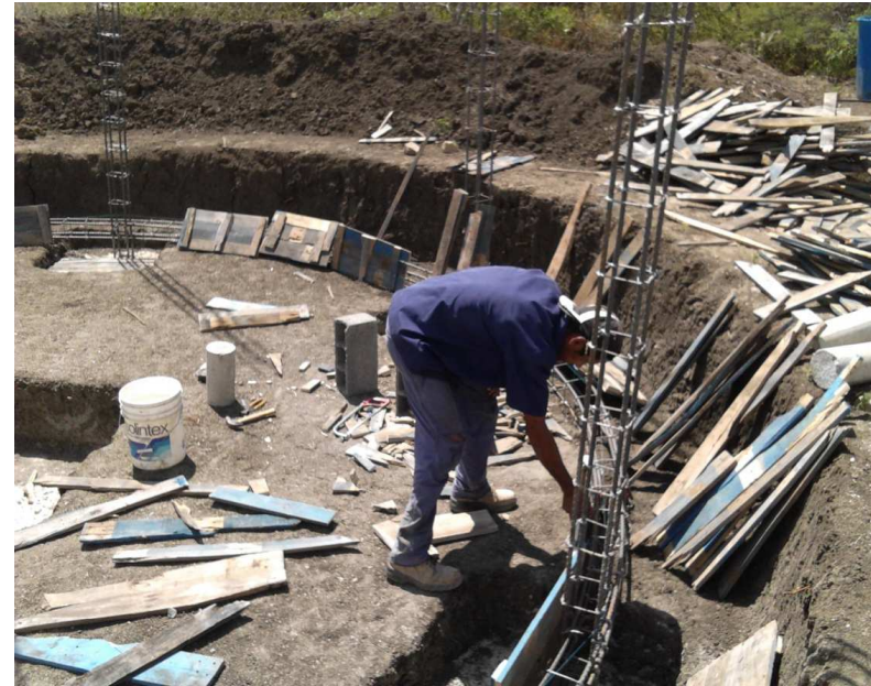
03 de octubre: construcción del encofrado de madera para el vaciado de concreto.
