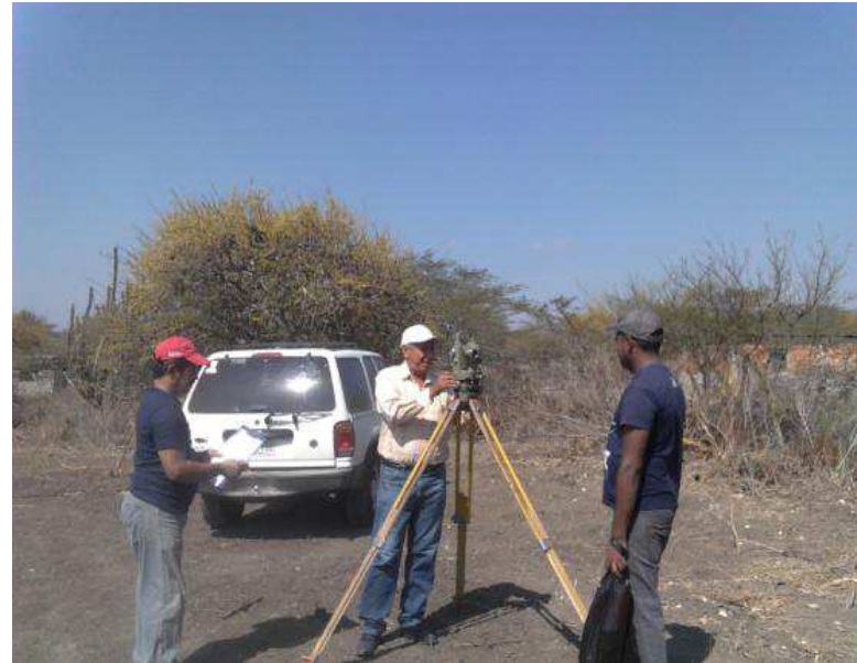
27 de enero de 2013. Replanteo de la orientación de la cúpula y disposición de los puntos cardinales.
